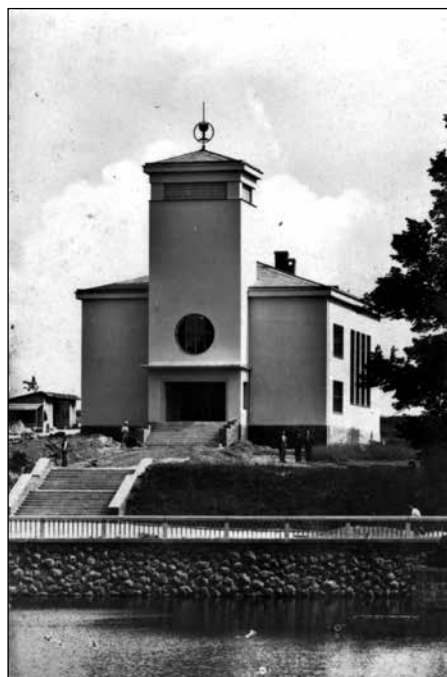
Dokončování schodiště ke kostelu
